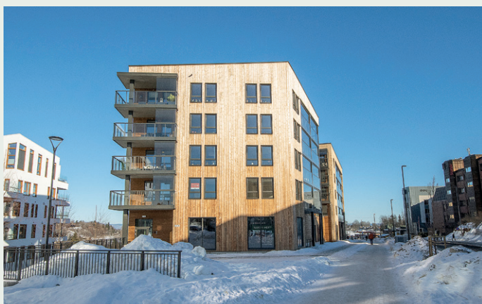
Fusdal Torg henvender seg mot Asker sentrum med et Kebony-kledd bygg med et eget torgareal foran.
